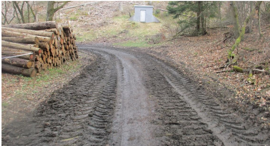
Abbildung 140: Beispiel einer Radwegeverbindung, die nach Forstarbeiten nur noch eingeschränkt nutzbar ist (eigenes Foto (VAR+, 2021))
