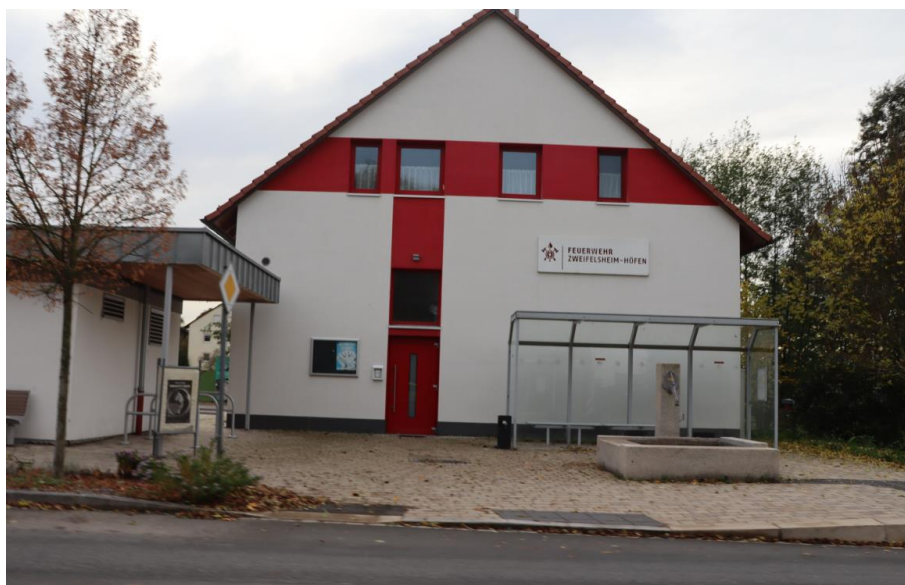
Abbildung 119: Fahrradabstellanlage an der Feuerwehr Zweifelsheim-Höfen (eigenes Foto (VAR+, 2022))
